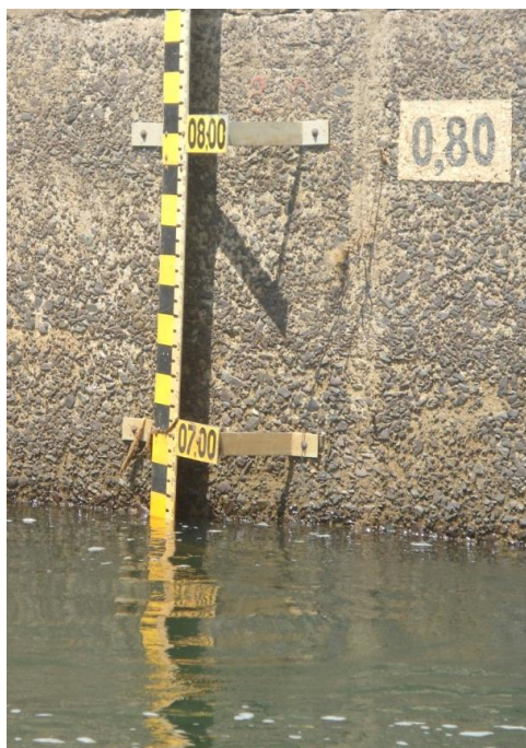
Figura 5.3 Condição nível Barragem.
