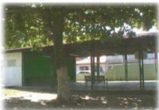
Figura 7. Vista para o Barracão.
