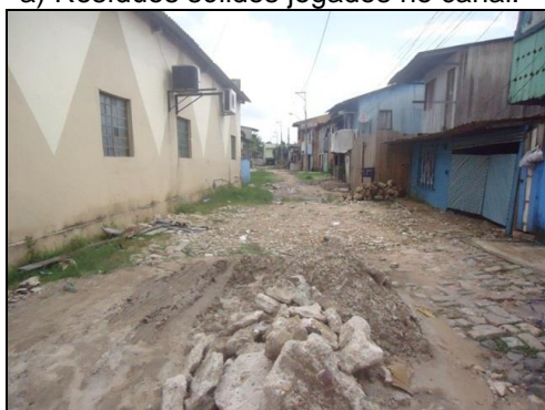
c) Rua aterrada para conter os alagamentos.
