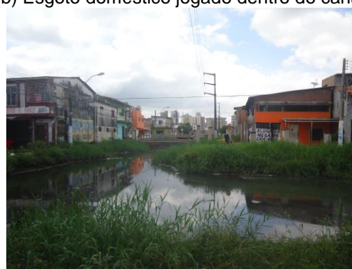
(d) Curvatura do canal da 14 de Março, ponto crítico de alagamento.
