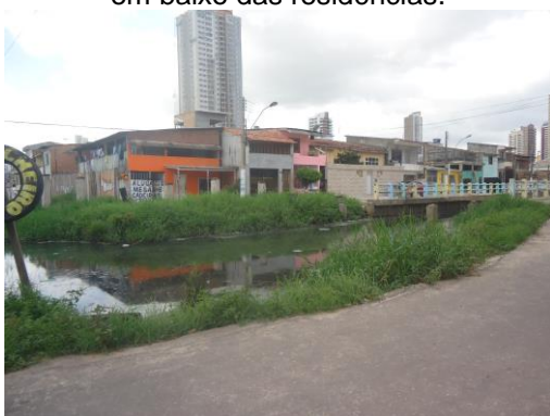
(e) Parte do canal da 14 de Março revitalizado e a outra parte a espera do projeto ser finalizado.
