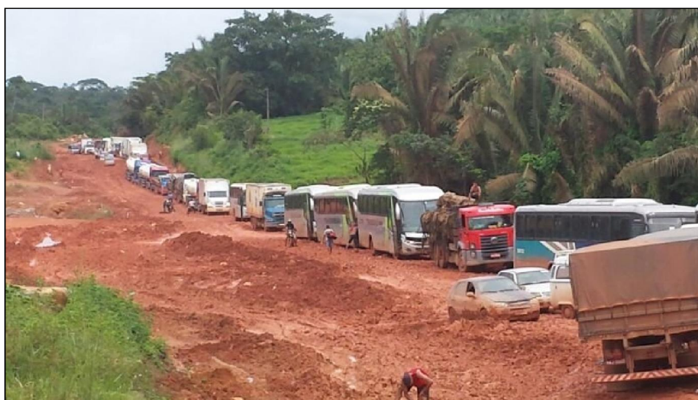
Figura 42. Rodovia BR-230 entre Novo Repartimento e Pacajá (PA) intrafegável.
