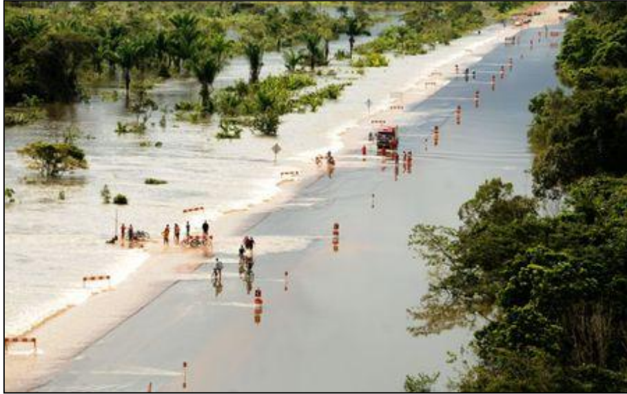
Figura 34. BR-432 inundada com o tráfego interrompido.
