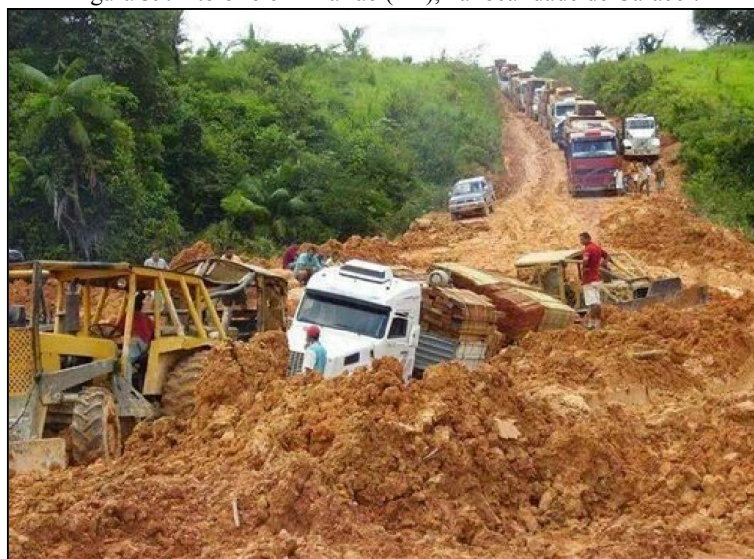
Figura 39. Atoleiro em Trairão (PA), na localidade de Caracol.
