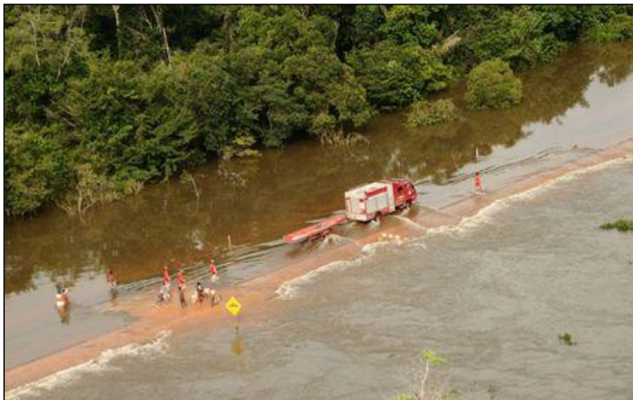
Figura 35. BR-174 com o tráfego interrompido no município de Caracarái, RR.
