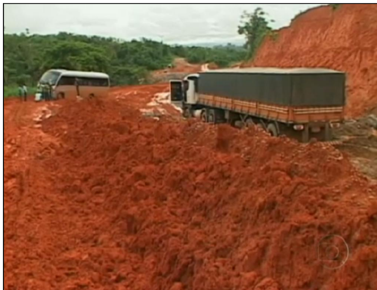
Figura 40. Rodovia BR-230 em Altamira-PA interrompida.
