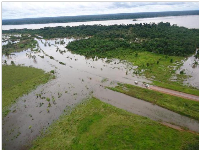
Figura 38 – Rodovia BR-425 nas proximidades de Guajará-Mirim-RO.
