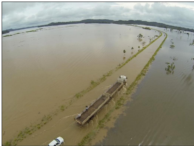
Figura 37. Rodovia BR-364 inundada próximo de Porto Velho-RO.
