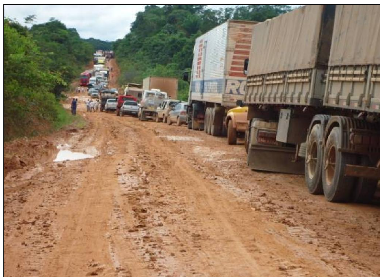
Figura 41. BR-163 sem condições de tráfego.
