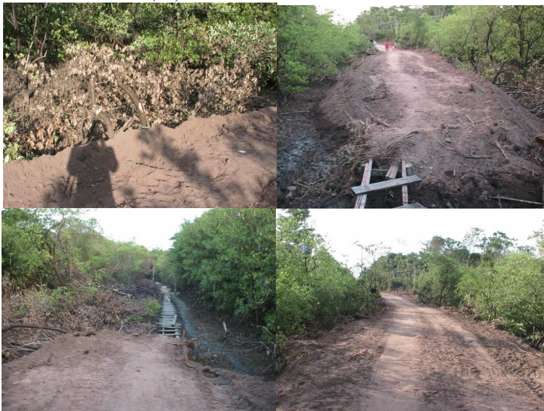
Fotografia 5 - Construção de uma estrada no meio de mangues, Vila São João dos Ramos, São Caetano Odivelas (PA).
