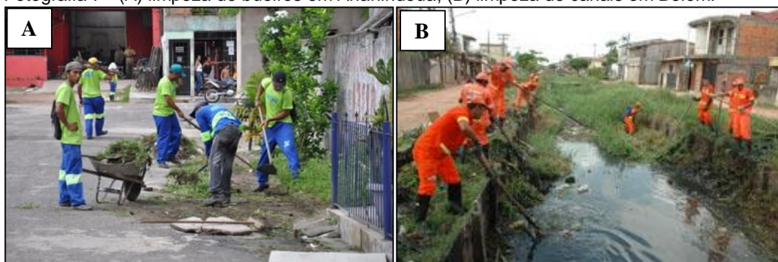
Fotografia 7 - (A) limpeza de bueiros em Ananindeua; (B) limpeza de canais em Belém.
