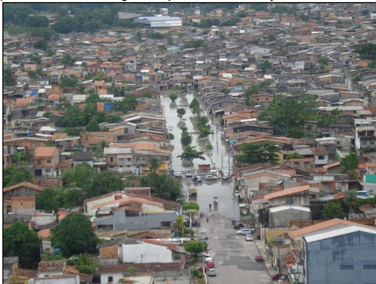
Fotografia 1 - Área de baixada com construções irregulares e problemas de drenagem, sujeita à inundação em Belém.
