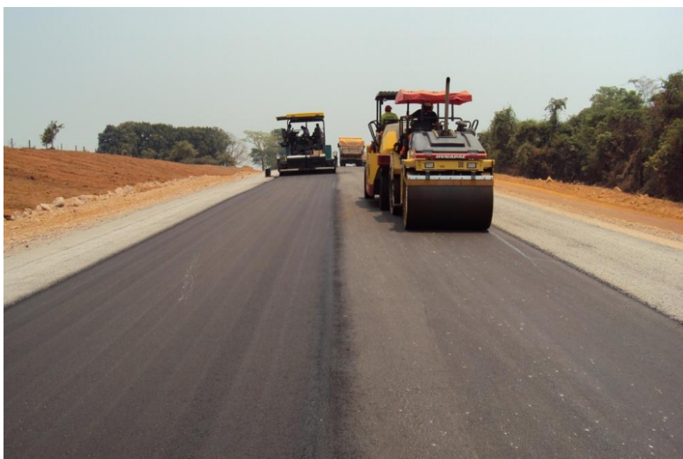
Fotografia 2 - Pavimentação da travessia urbana de Novo Progresso.
