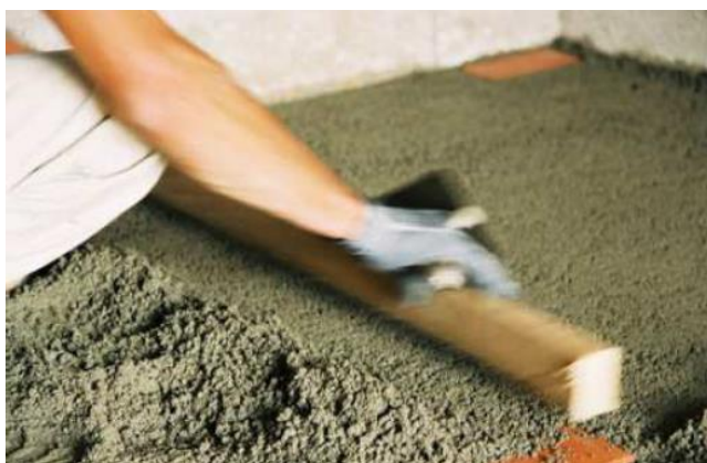
Figura 2.2 – Aplicação da argamassa em contrapiso convencional. Fonte: (SOUZA, 2013)
