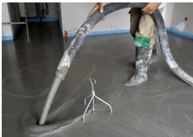
Figura 2.1– Aspecto da argamassa autonivelante durante sua aplicação. Fonte: (GUGELMIN, 2013)
