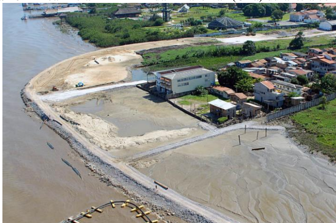
Figura 16 – Área inicial do “Portal da Amazônia” (Orla) durante a construção.
