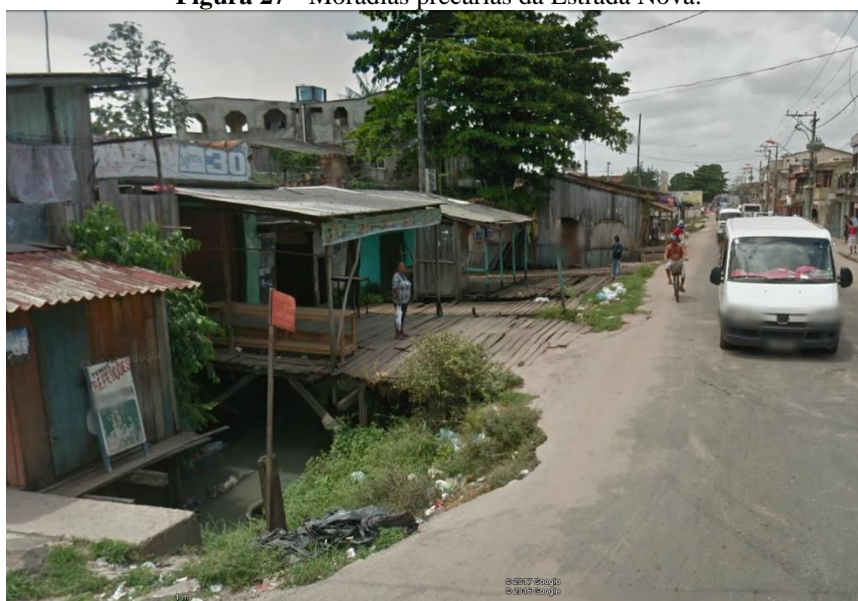
Figura 27 - Moradias precárias da Estrada Nova.
