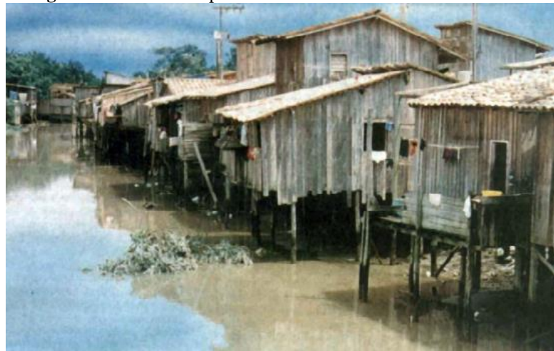
Figura 3 – Palafitas: aspectos da moradia nas baixadas em Belém.
