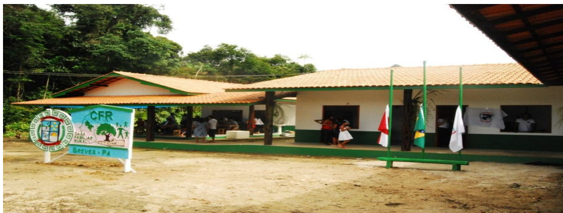
Fotografia 17- Área externa do refeitório da CFR de Breves.
