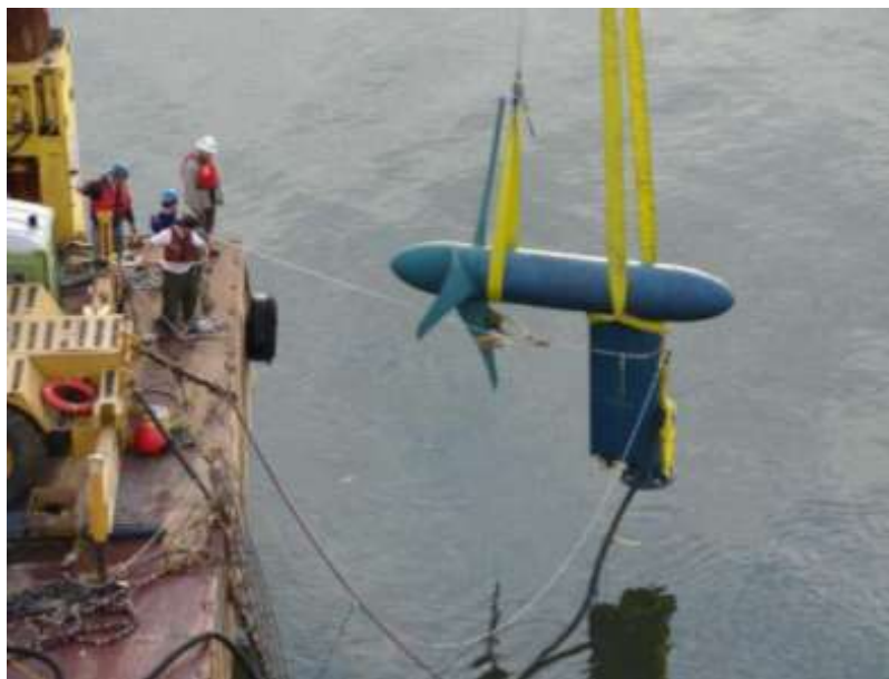
Figura 1.4: Turbina hidrocínética Verdant Power 35 kW (Sale et al. , 2009).
