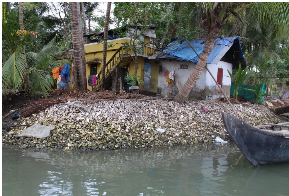
Fotografia 9 - Muros construídos com cascas de ostras na RCKV
