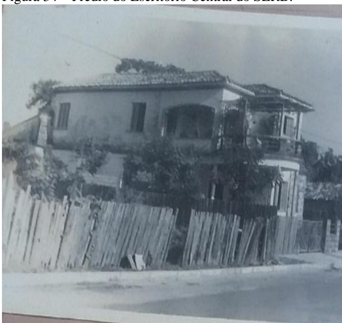
Figura 34 – Prédio do Escritório Central do SERB.
