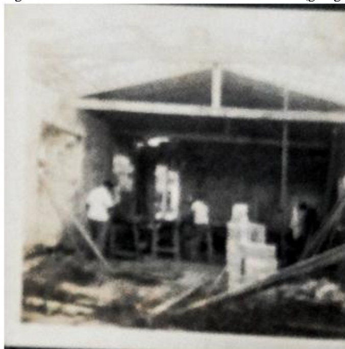
Figura 33 – Oficina anexa ao Escritório do SERB (garagem).
