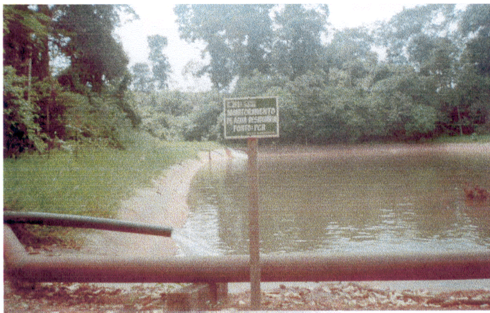
Figura 15 - Tanque de recuperação da água acumulada nas bacias, que retorna para o circuito de moagem.
