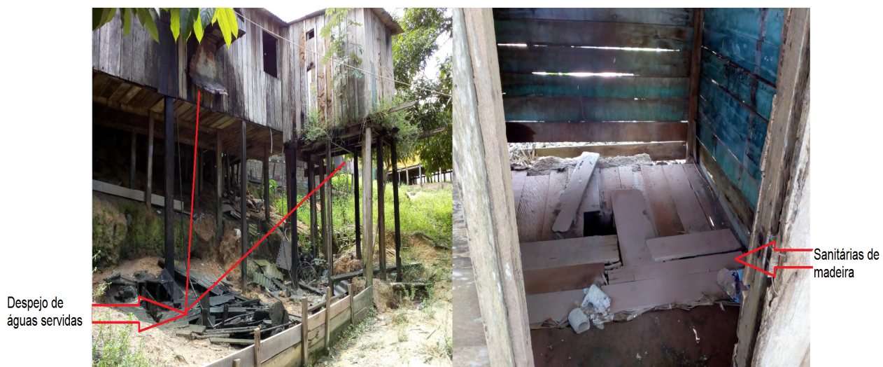
Figura 32 - Estruturas de madeira.
