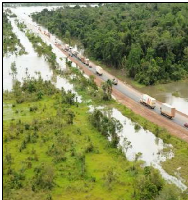
Parte da BR 174 que liga Boa Vista a Manaus submersa pelo avanço do nível das águas. Comprometimento do escoamento da produção
