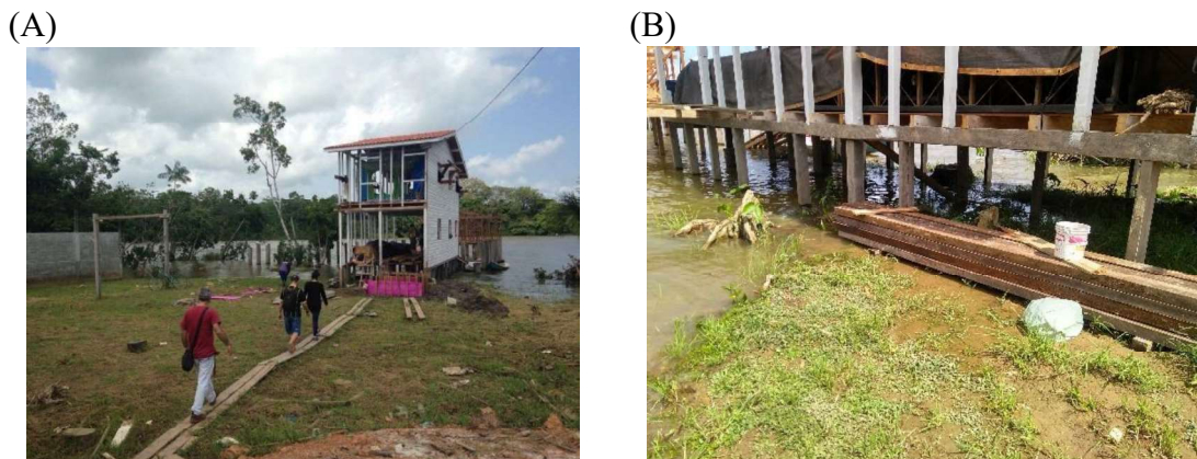
Figura 11 - Ponto “P3”. (A) Visão geral da área visitada. (B) Construção em planície de inundação.
