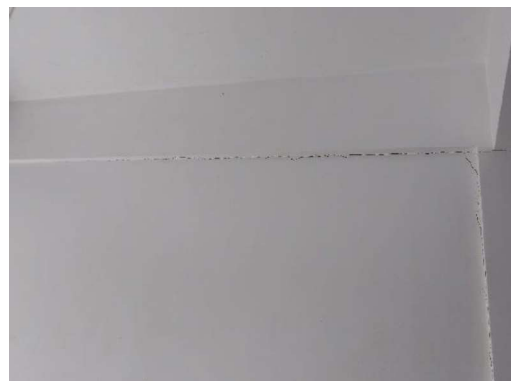
Figura 14 - Ponto “P5”. (A) e (B) Trincas.
