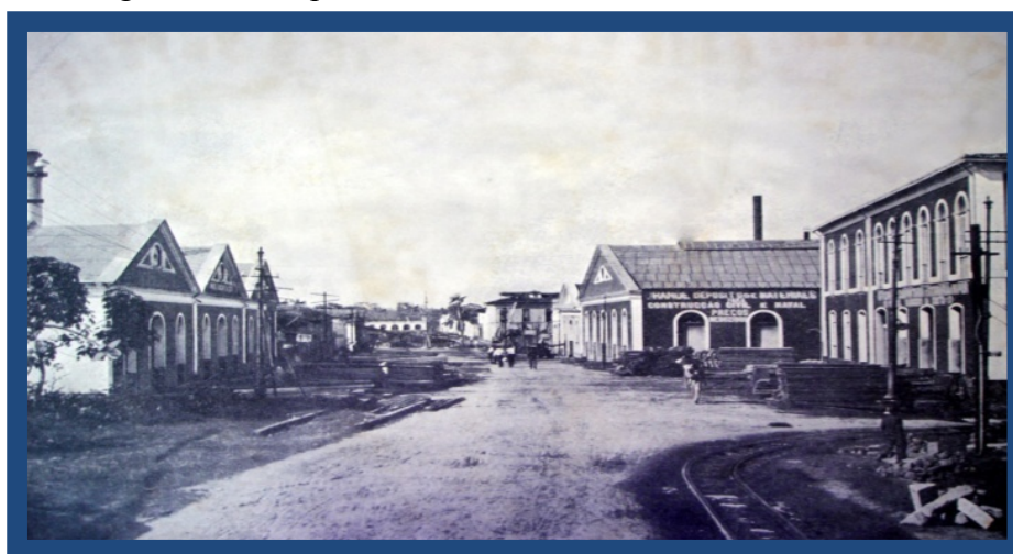
Figura 10 – Galpões das Oficinas “Carniceiro” em Belém, 1900
