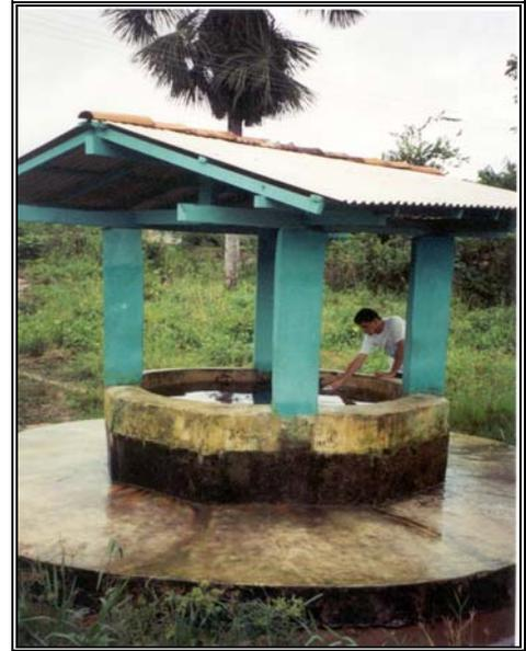
**Figura 20** – Poço aberto do Bocal, cidade de Maracanã. Local de topografia baixa (cerca de 6m abaixo do nível das ruas mais altas). Foto obtida no período chuvoso de 2003; observa-se apreciável aumento de nível hidrostático, praticamente à borda de proteção do poço, tendo a prefeitura procedido recuperação do abrigo. No entorno do terreno permanece forte ação antrópica (contínuo movimento de “banhistas” no fim de semana, bem como circulação de animais de criação).
