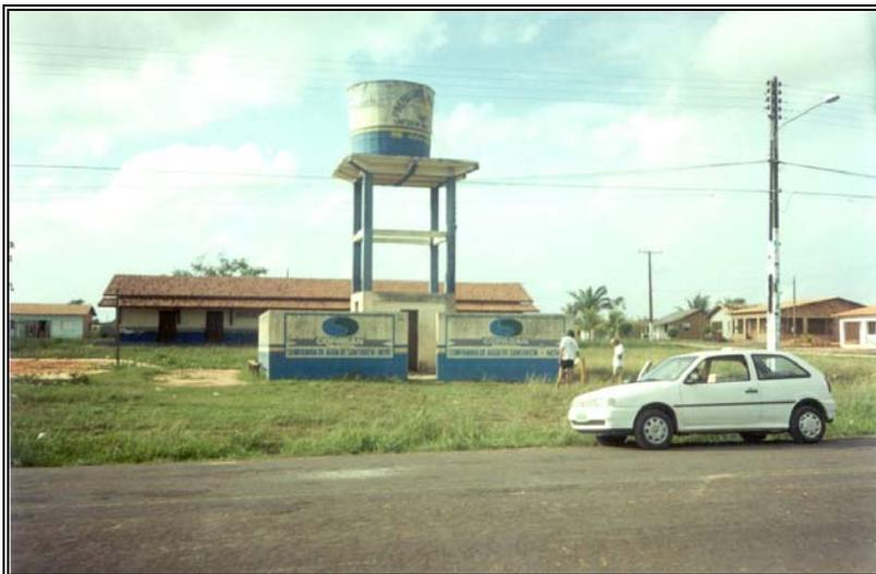
**Figura 15** – Santarém Novo, captação de água subterrânea (COPASAN); situada em terreno de topografia elevada (cotas acima de 40m em relação ao nível do mar). Localizada à margem da rodovia PA-438, já dentro da cidade. Água potável de excelente qualidade.
