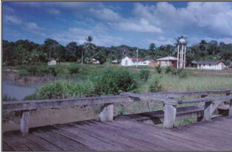
**Figura 14** – Bacuriteua, captação de água subterrânea; terreno de topografia baixa (cotas inferiores a 4m em relação ao nível do mar), pertencente à prefeitura de Santarém Novo. Localiza-se a 100 m do barranco às margens do rio Maracanã, observando-se influência de sedimentos holocênicos do mangue. Trata-se de água de excelente qualidade. Aparentemente, não sofre efeitos da sazonalidade.
