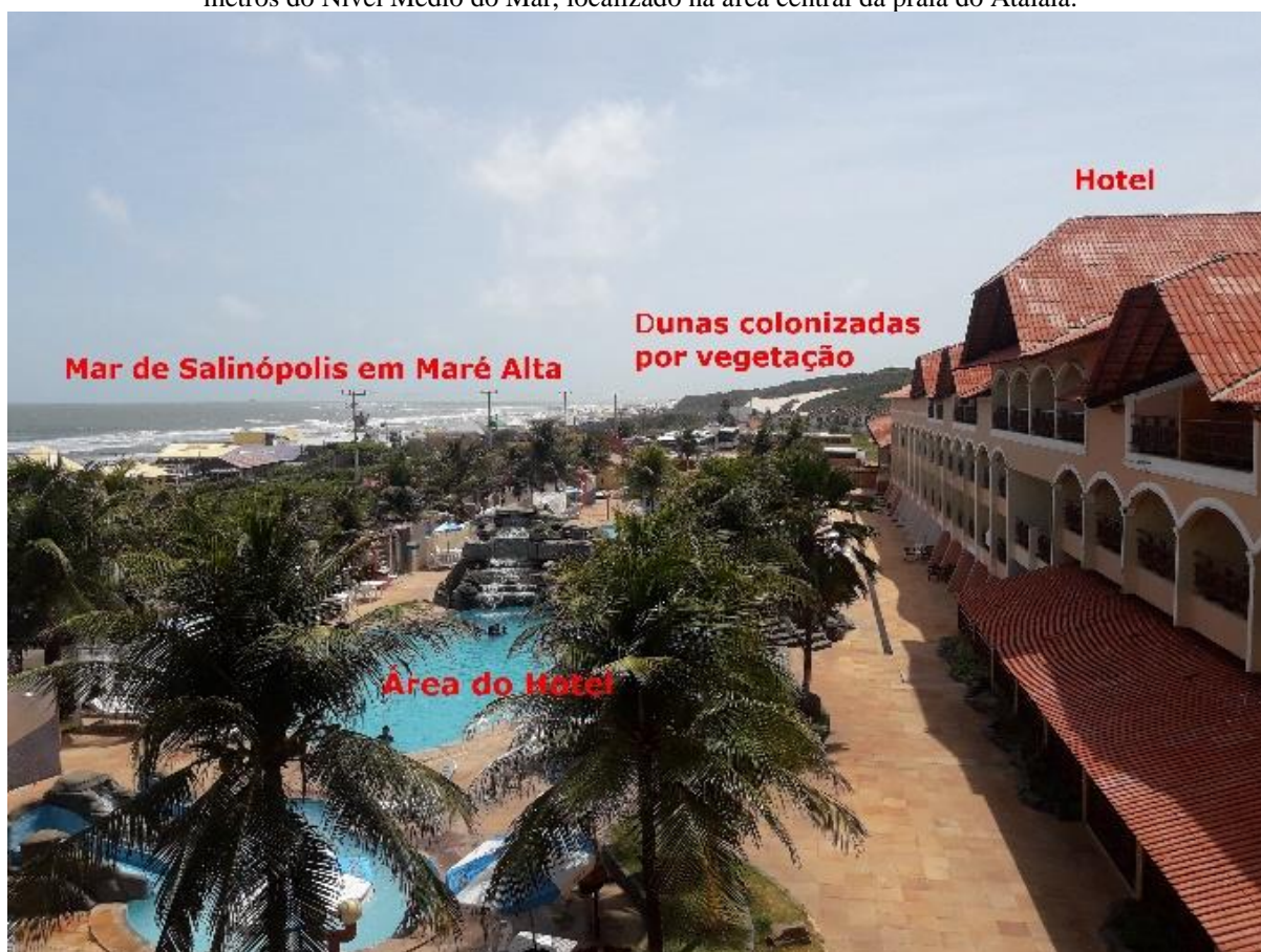
Figura 3.18- Hotel construído à 50 metros de distância da linha de espraiamento das ondas em maré alta e a 7 metros do Nível Médio do Mar, localizado na área central da praia do Atalaia.
