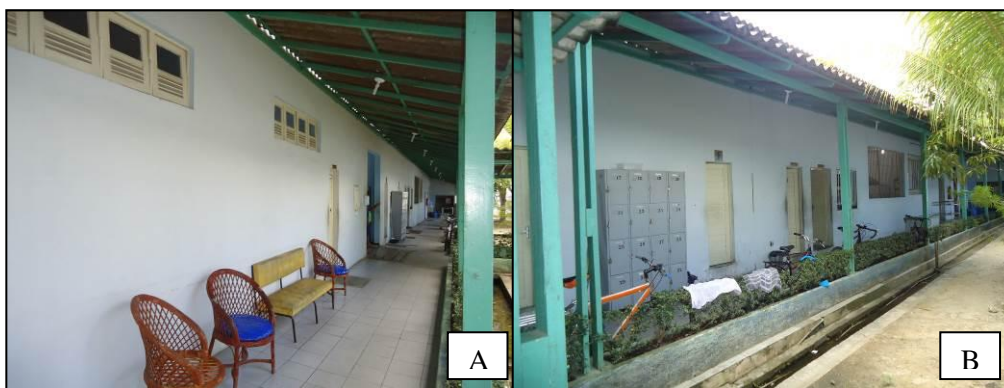
Figura 10 A e B - Salas do setor técnico e administrativo da UAPI 2.
