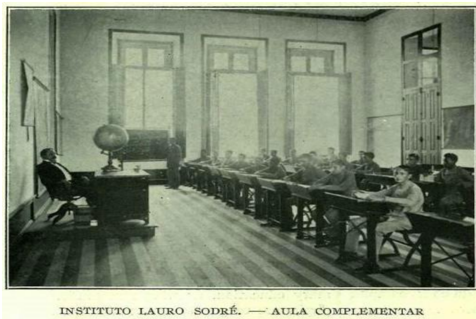
Figura 31: Sala de aula complementar no Instituto Lauro Sodré – seção masculina
