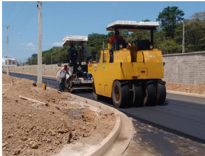
Figura 4.19 - Rolo pneumático usado na pavimentação.
