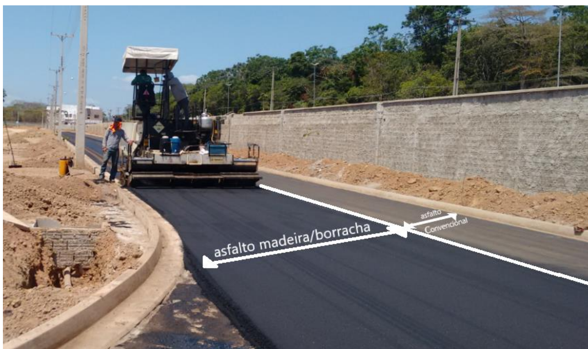
Figura 4. 20 - Asfalto madeira/borracha e asfalto convencional.
