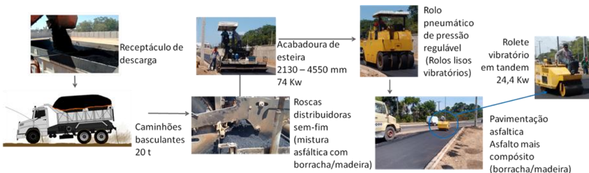
Figura 4.17 - Pavimentação de trecho urbano com asfalto convencional e modificado.
