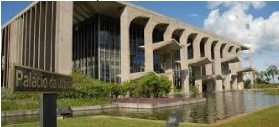
Figura 3–Prédio do Ministério da Justiça em Brasília (DF).
