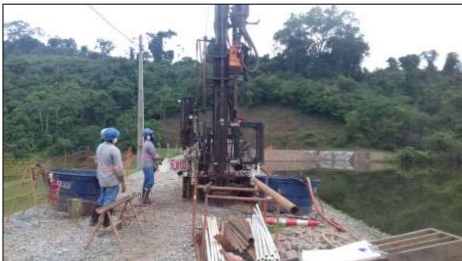
Figura 50: Sondagem na Crista da Barragem, 2017.
