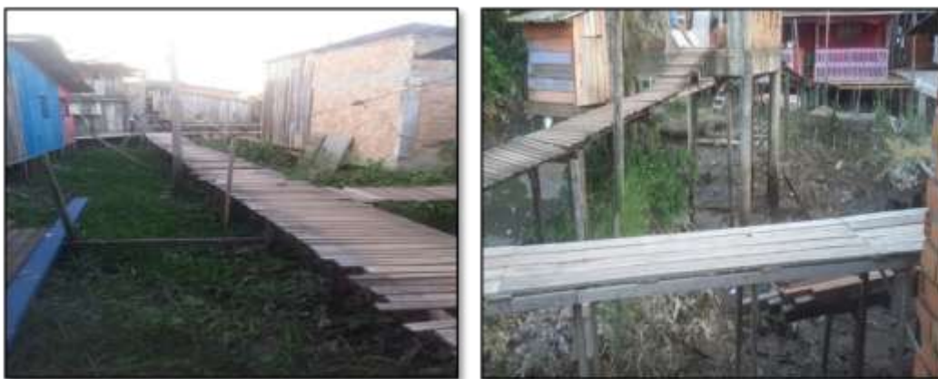
Figura 6 - Lançamento de esgoto diretamente nos rios sem nenhum tipo de tratamento no bairro Agulha localizado no Distrito de Icoaraci, Belém/PA.
