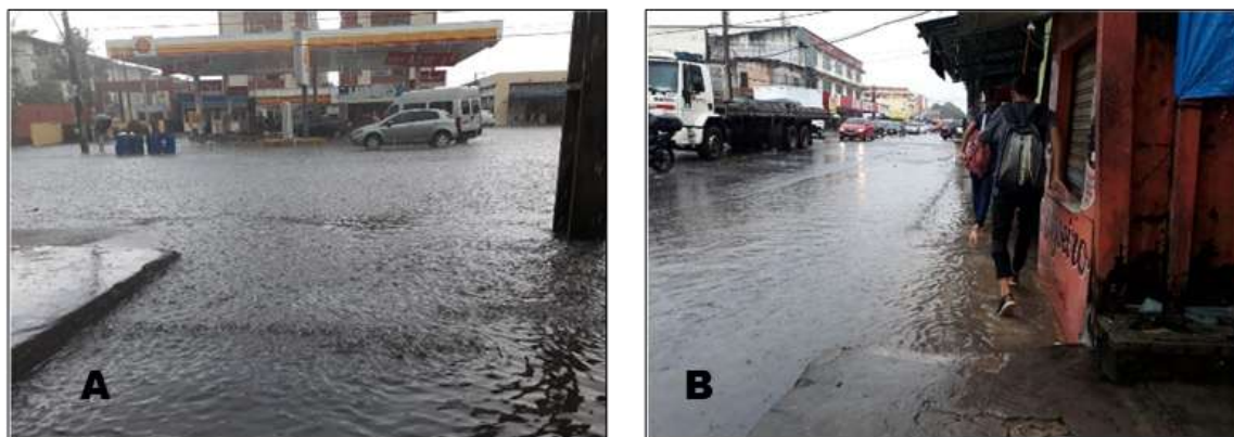
Figura 13- Pontos de alagamentos no bairro da Marambaia no município de Belém/PA.
