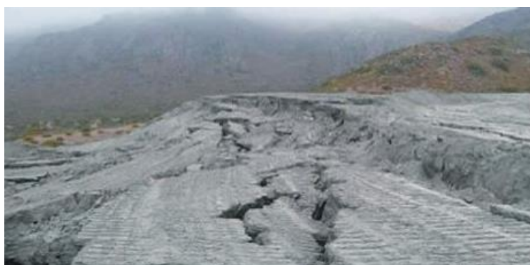
Figura 4 – Exemplo de dano (trincas e deslizamento do talude a jusante) causado a barragem de rejeito de mineração por terremoto ocorrido no Chile em 2010.
