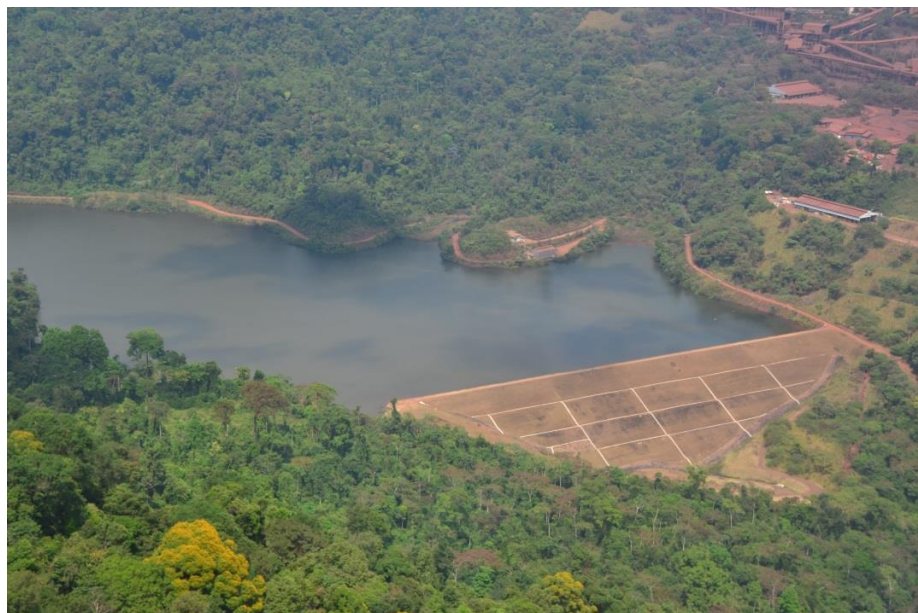
Figura 14 – Vista aérea da barragem Pera Jusante.
