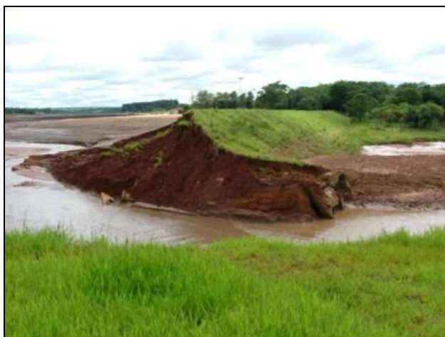
Figura 2 – Exemplo de barragem de mineração situada no Brasil rompida por galgamento em 2007.
