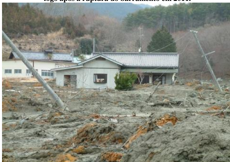
Figura 6 – Foto do vale a jusante da barragem de Kayakary (Japão) afetado pelo deslocamento do rejeito logo após a ruptura do barramento em 2011.
