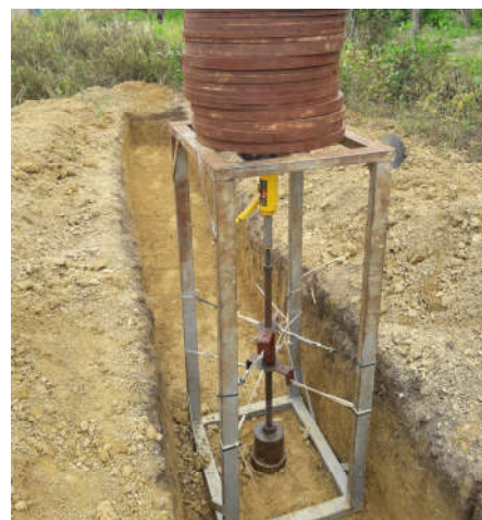
Utilização do sistema de cravação
