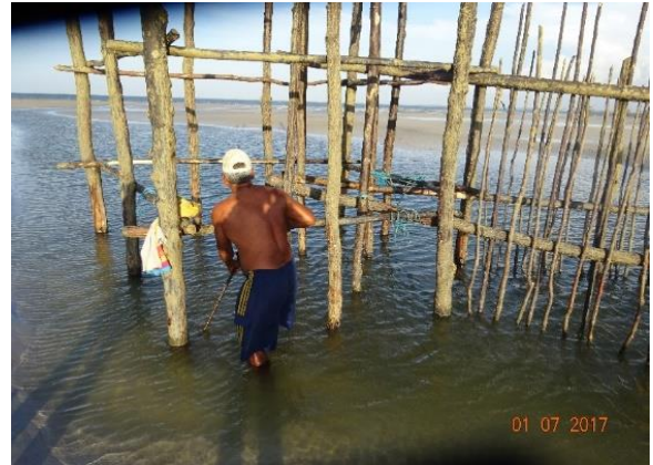
Foto 39: Desmonte de chiqueiro.
