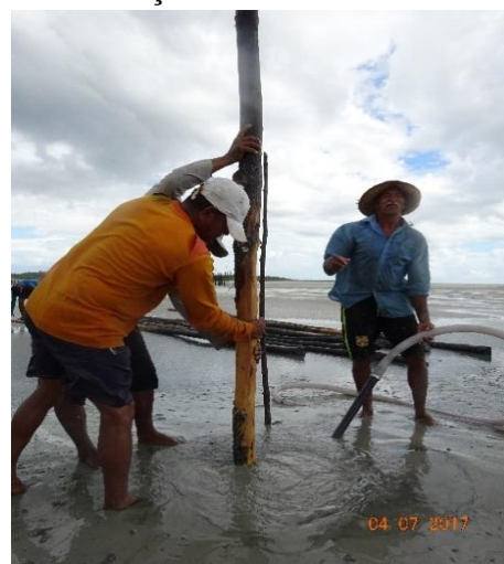
Foto 41 – Utilização de bomba d'água para instalação do mourão.
