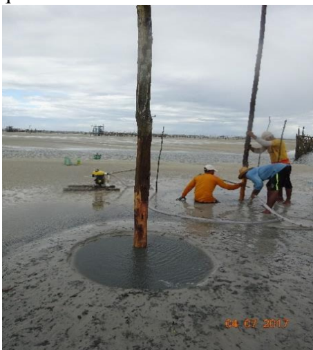
Foto 40: Instalação da viga mestra do chiqueiro.
