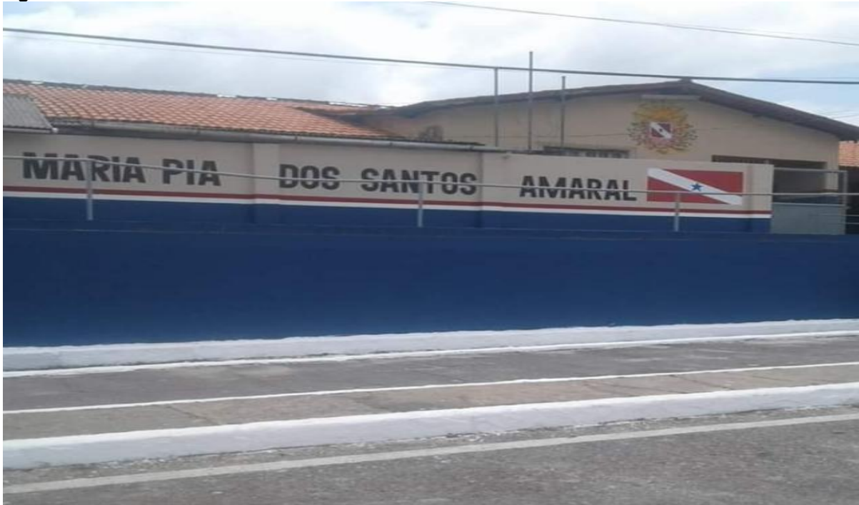
Figura 2: Fachada da escola Maria Pia.
