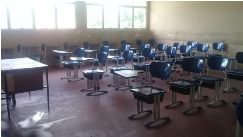
Imagem 11 – Sala de aula.
