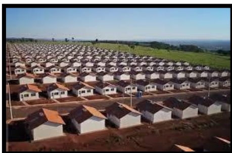
Imagem 19 – Vista Aérea da COHAB J. Pizolato
