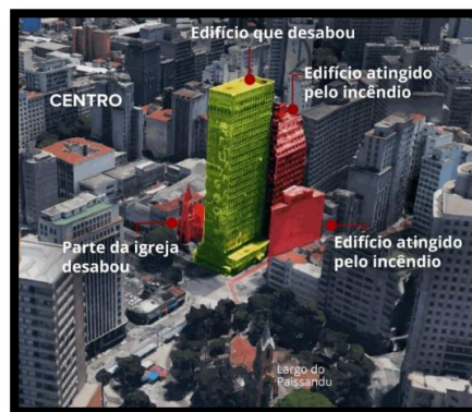
Imagem 08- Edifício Wilson Paes desaba no dia 1º de Maio na cidade de São Paulo Fonte: https://g1.globo.com/sp/sao-paulo/noticia/incendio-atinge-predio-no-centro-de-sp.ghtml
