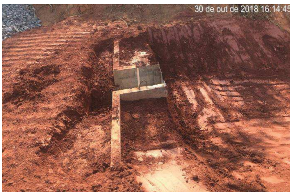
3.0 Limpeza e retirada do material para proceder com o lançamento da areia compactada - 3AF-C.
