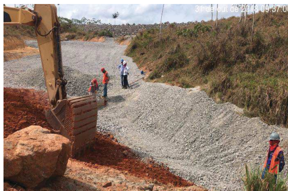
4.0 Início do enrocamento compactado.
