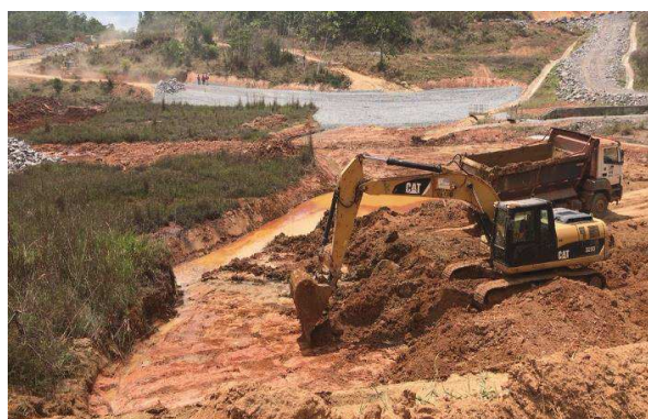
5.0 Limpeza e retirada do material para proceder com o lançamento da areia compactada - 3AF-C.
