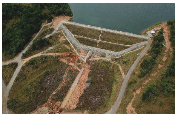
4.0 Identificação por meio da vista aérea das surgências de água a jusante do Dique.
