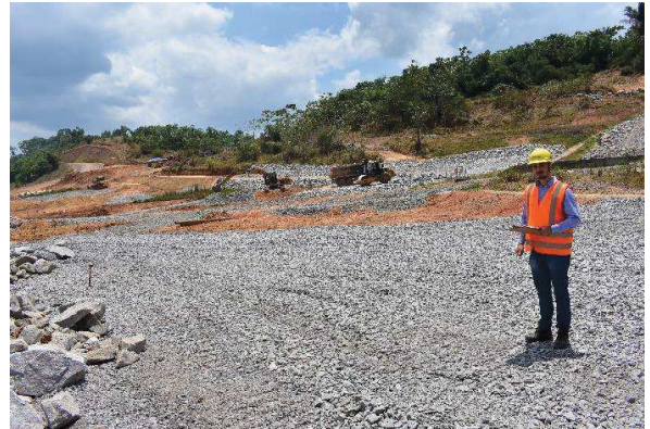
10.0 Assentamento do enrocamento compactado.
