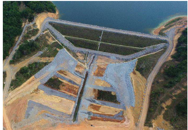
12.0 Dreno invertido concluído.
