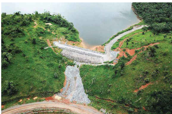
5.0 Aterro de proteção do talvegue - filtro invertido concluído.
