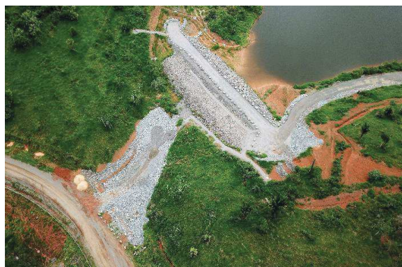
6.0 Aterro de proteção do talvegue - filtro invertido concluído.
