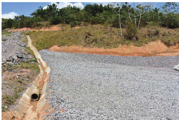
9.0 Conclusão do lançamento da transição compactada com uso da 4A'-C.
