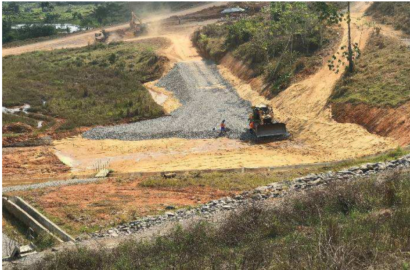
7.0 Início do lançamento da transição compactada com uso da 4A'-C.
