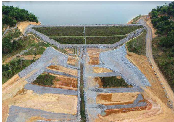
11.0 Dreno invertido concluído.
