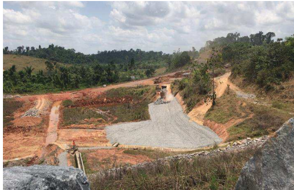
8.0 Avanço da transição compactada com o início do enrocamento compactado.
