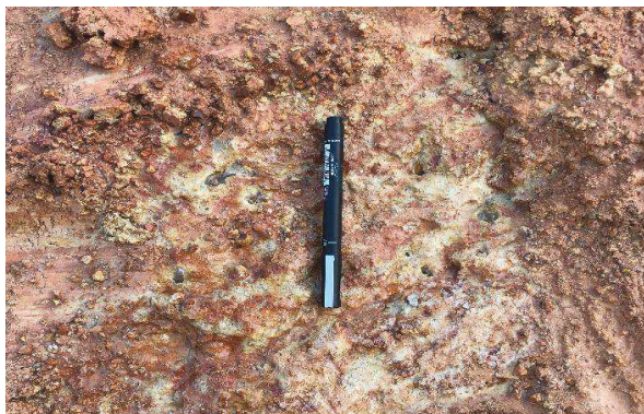
1.0 Identificação de canalículos com surgências de água.
