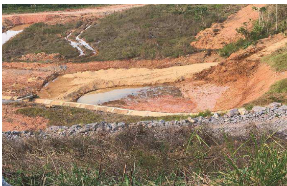
6.0 lançamento da areia compactada para proceder com o assentamento da transição compactada com uso da 4A'-C
