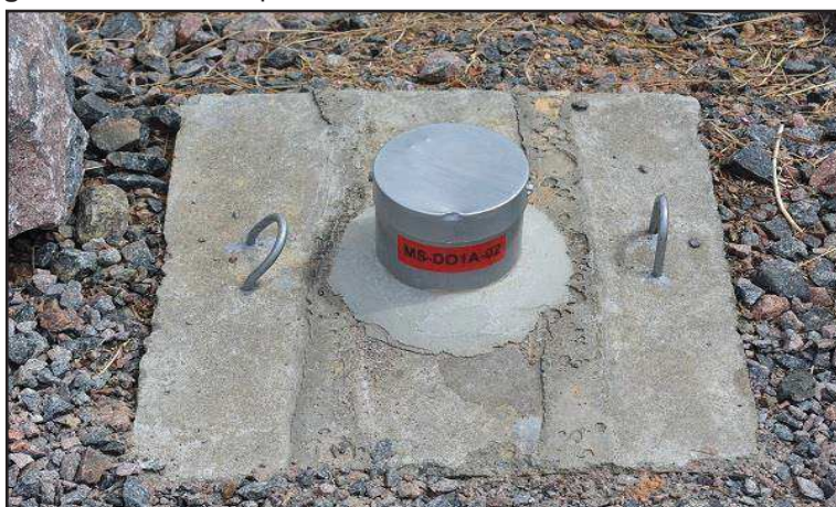
Figura 12 - Marco Superficial – DIQUE 01-A UHE – BELO MONTE
