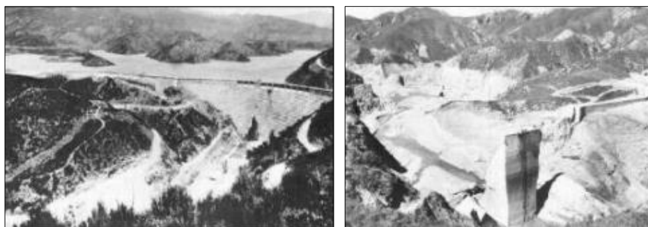
Figura 1 - Vista da barragem de ST Francis antes e após o rompimento.
