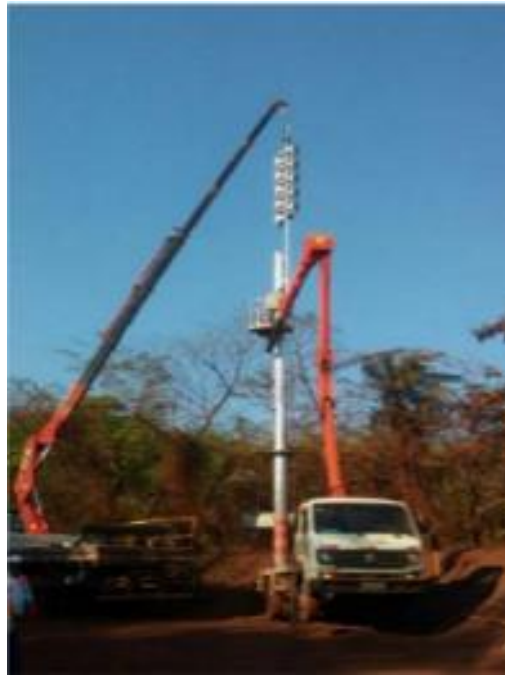
Figura 19 - Torre de alerta de emergência em processo de implantação.
