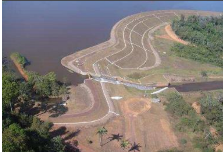
Figura 21 - Vista área da barragem do Gelado.
