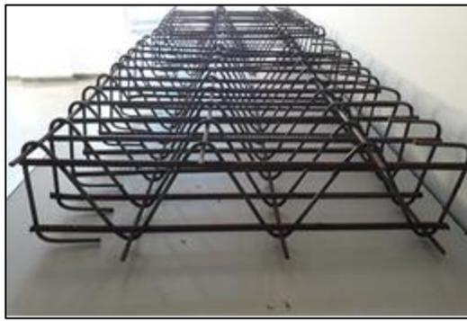
a) Armadura transversal pré-fabricada
