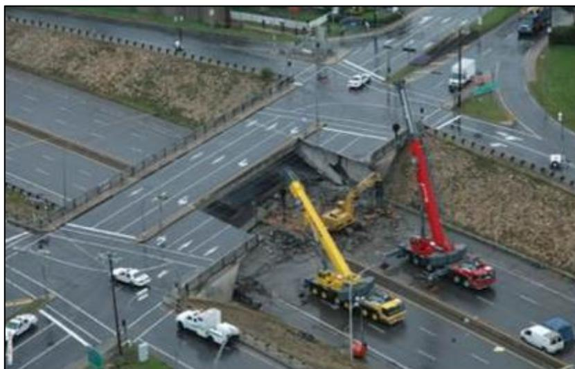
**Figura 1.1- Colapso unidirecional viaduto de La Concorde (REPORT 2007).**
