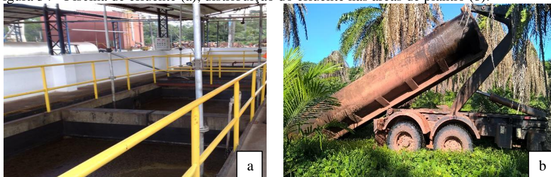
Figura 34 - Piscina de efluente (a), distribuição do efluente nas áreas de plantio (b).
