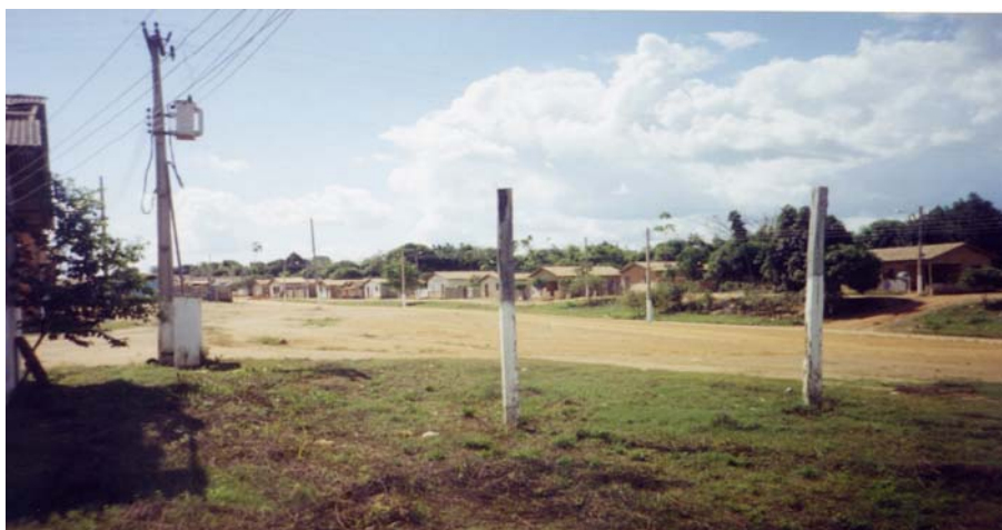
Foto 6 Rua da Palmeiras II destacando rede elétrica.
