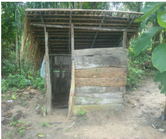
Foto 5: Banheiro. Fonte: Trabalho de campo, 2009.
