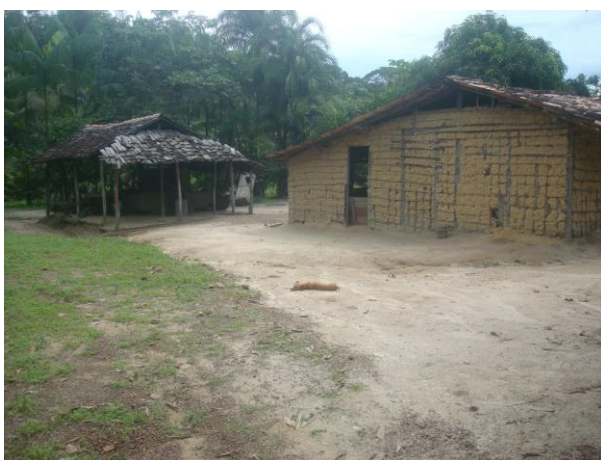
Foto 1: Fachada de uma casa de barro de uma família da comunidade São João. Fonte: Trabalho de campo, 2009.
