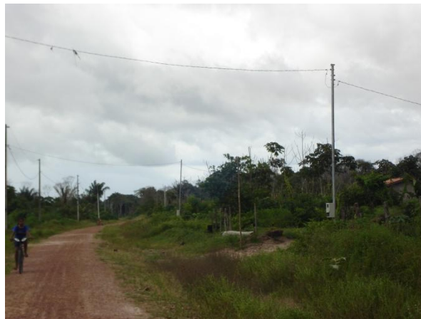
Fotografia 7: Instalação de energia elétrica nas casas dos assentados.
