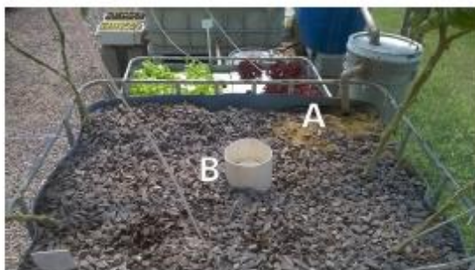
Figura 9. Ambiente com pedra brita para suporte ao enraizamento dos vegetais e colonização por bactérias (filtro biológico). (A) Entrada da água vinda do filtro de sólidos em suspensão. (B) Tubo de PVC de 160 mm com 26 cm de altura que separa a pedra brita do sifão de sino instalado na saída da água.
