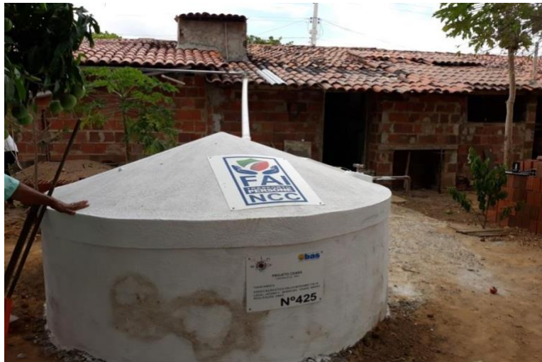
Figura 2 – Cisterna construída no quintal de uma das famílias entrevistadas
