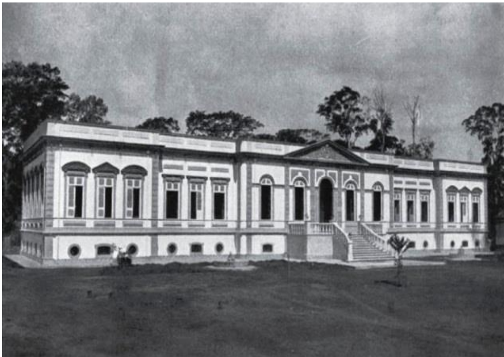
Figura 1 – Hospital de Isolamento Domingos Freire
