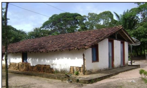
Foto 11: Casa de pau a pique coberta com telha de barro. Fonte: FERNANDES, Thiara, pesquisa de campo, maio/09
