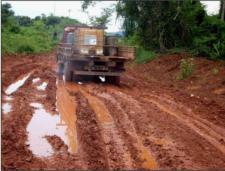
Figura 12: Estrada localizada a menos de 10 km da vila Carapanã (Tucumã). Após as primeiras chuvas (06 dez. 2008). Fonte: LEVANTAMENTO DE CAMPO, 2008
