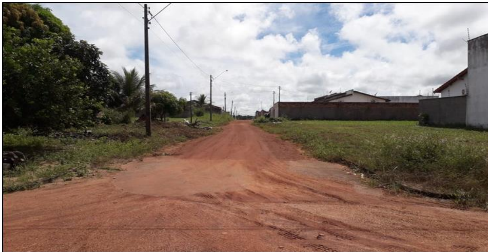
FOTO 3 – RUA DO RESIDENCIAL JARDIM AMÉRICA: de acordo com o site da Buruti Empreendimentos, o loteamento foi entregue à Prefeitura com todas as ruas asfaltadas e com todos os postes de iluminação funcionando, porém, o que se observa é que, no verão, os moradores precisam lidar com a constante poeira e, no inverno, com as poças de lama nas vias. Foto: Ernando Ribeiro, janeiro de 2020.
