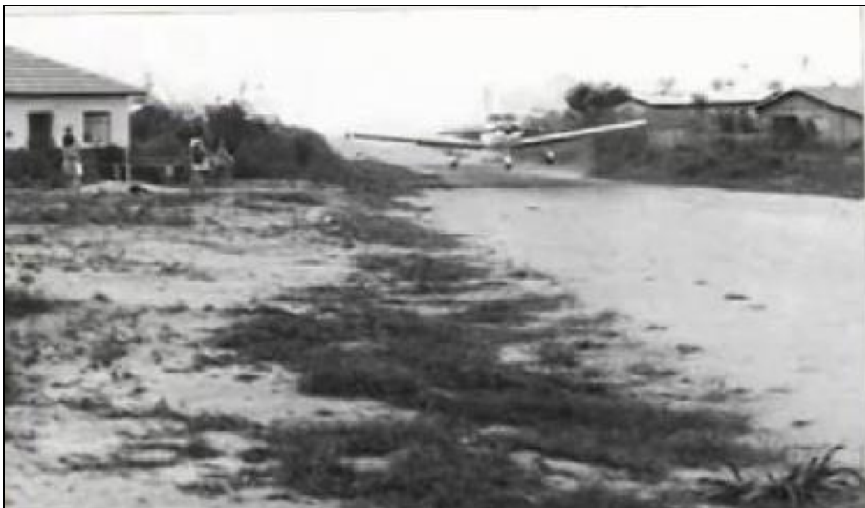
FOTO 1 – ANTIGA PISTA DE POUSO ONDE HOJE EXISTE A AVENIDA SANTA TEREZA: as edificações nas margens da pista apresentam o início da ocupação urbana que ocorria no vilarejo de Boca da Mata.
