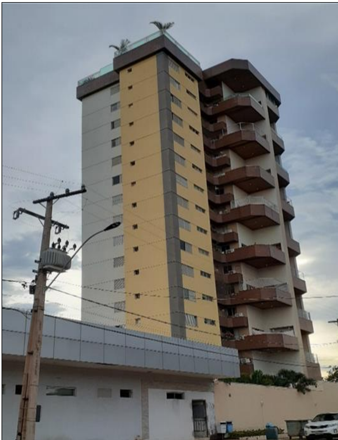
FOTO 6 – CONDOMÍNIO CASTANHEIRA: o edifício é composto por um apartamento em cada andar e cada um com 4 suítes, contando, também, com área de lazer compartilhada, duas piscinas e dois elevadores.
