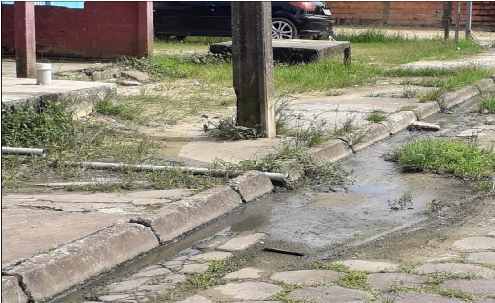
FOTOGRAFIA 13 – EFLUENTES DOMÉSTICOS DESCARTADOS DIRETAMENTE NO MEIO-FIO: Comunidade Fé em Deus. FOTO: Marlon D'Oliveira Castro, junho de 2019.
