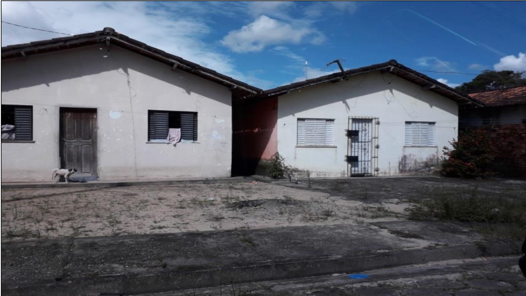
FOTOGRAFIA 11 – UNIDADES HABITACIONAIS DA COMUNIDADE FÉ EM DEUS APÓS AS OBRAS DO PAC. FOTO: COHAB, 2014.
