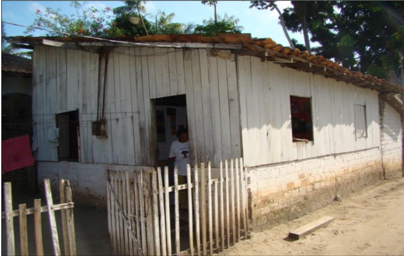
FOTOGRAFIA 10 – RESIDÊNCIA DA COMUNIDADE FÉ EM DEUS ANTES DAS INTERVENÇÕES DO PAC. Foto: IAGUA, 2010.
