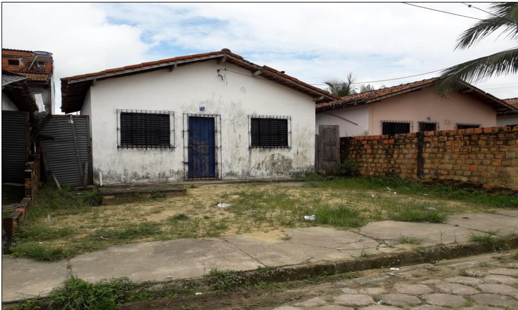
FOTOGRAFIA 15 – UNIDADE HABITACIONAL DA COMUNIDADE JARDIM JADER BARBALHO APÓS INTERVENÇÕES DO PAC.
