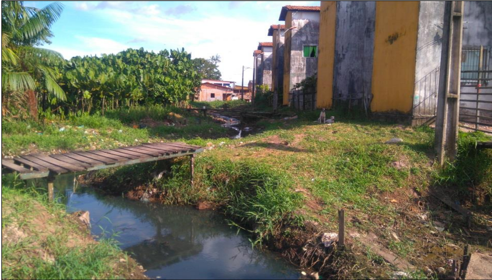
FOTOGRAFIA 01 – BLOCOS DO RESIDENCIAL IVY PORTELLA, EM ICOARACI: projeto PAC Paracuri. Intervenção realizada pelo Governo Federal em parceria com a Prefeitura Municipal de Belém (PMB) removeu famílias que habitavam igarapés da Bacia do Paracuri. As obras começaram em 2008 e ainda estão inacabadas.
