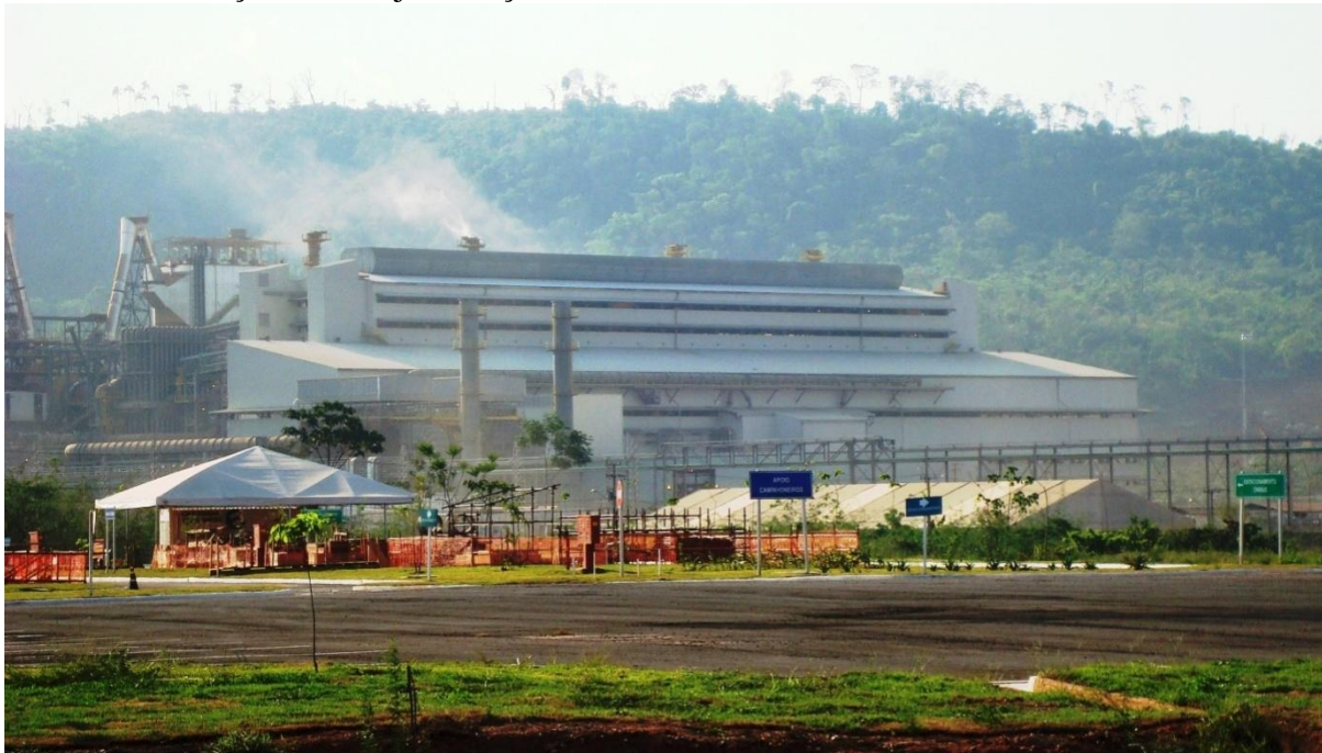
Foto 01 - Instalações do Projeto Onça Puma – Vicinal Picadão em Ourilândia do Norte – PA
