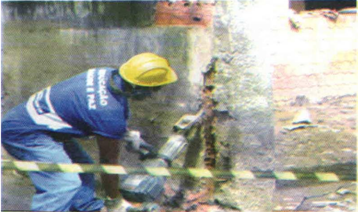
Foto 03 - Operário desmanchando a casa no PA Campos Altos adquirida pela MOP/Canico.
