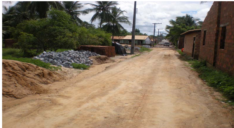
Fotografia 3b - Calçamento da Rua da Mangabeira
