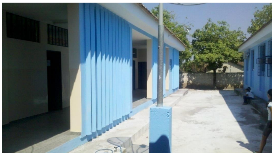
Imagem 1: Vista interna da Escola Campo.
