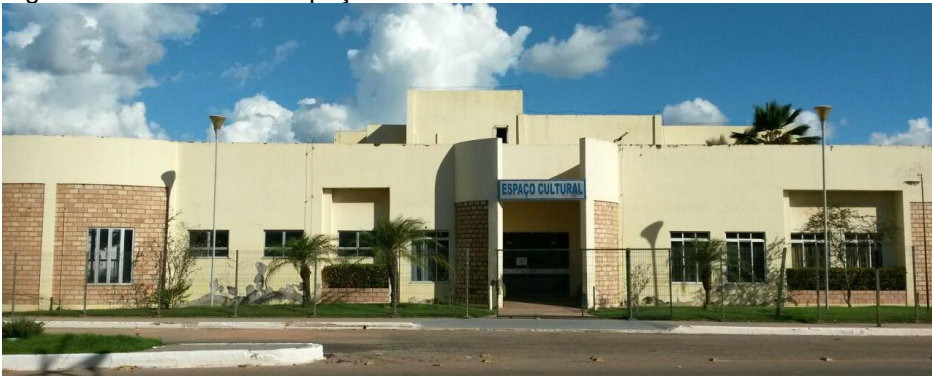
Figura 6 – Fachada do Espaço Cultural.
